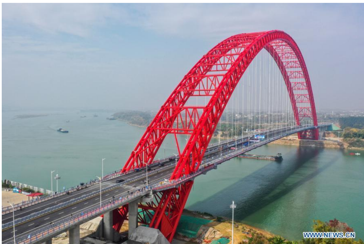
Рисунок 3 –Мост через р. Сюнь в уезде Пиннань провинции Гуанси с рекордной, на сегодняшний день, длиной пролёта в 575 метров построен в 2020 году.
