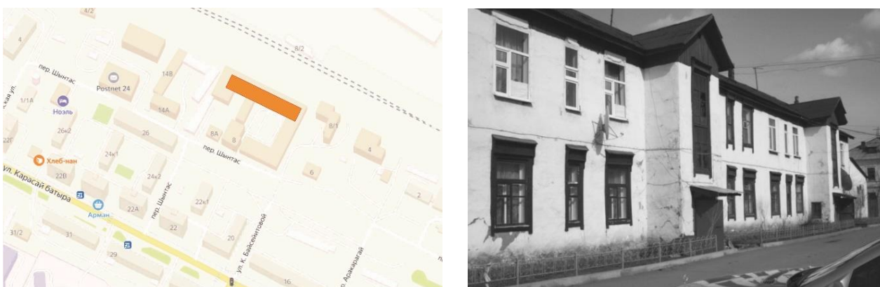
Рисунок 1 – Жилой дом постройки 1936 года по ул. Шынтас 9, г. Астана (материалы автора).
