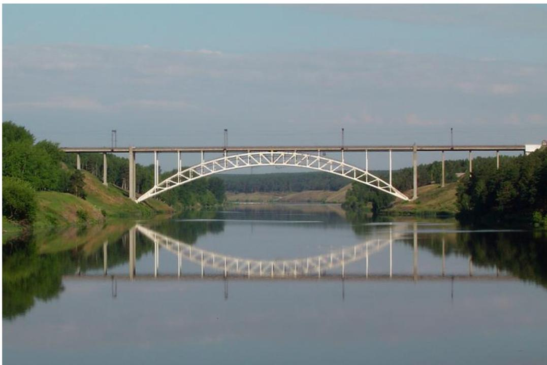
**Рисунок 1** – Арочный мост из трубобетона в г. Каменск-Уральский Свердловской области
